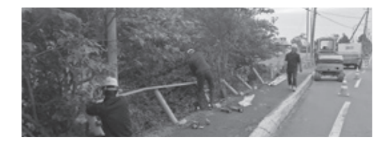
福中・西江経常建設共同企業体 (福中建設株式会社・西江建設株式会社) 温泉通り転落防止柵撤去
