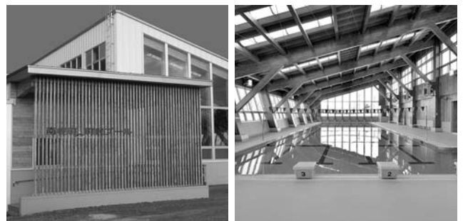
町民プールの整備
